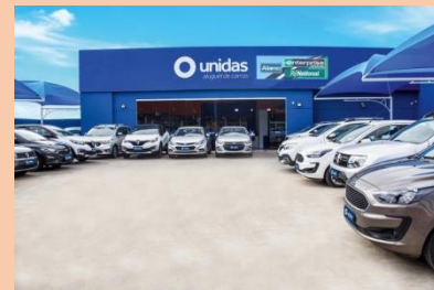
Área da edificação + pátio de carros
