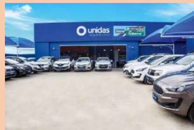
Área da edificação + pátio de carros
